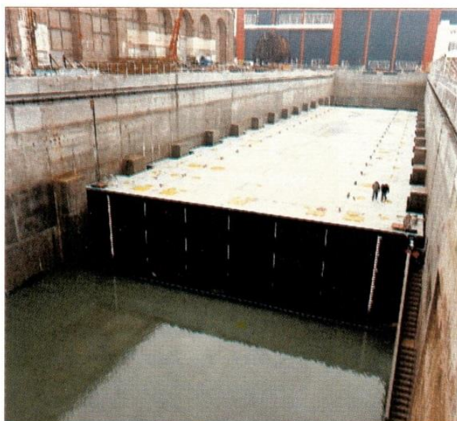
Plate-forme en cours de descente à vide lors d'essais de l'ouvrage Cachin. Les piles d'appui sont visibles de part et d'autre de la plate-forme.
