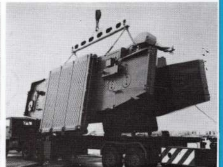
Levage d'un module Hoisting of module - Levantamiento de un módulo.
