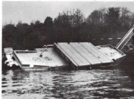
Mise à l'eau d'un module. Launching of a module Puesta al agua de un módulo
