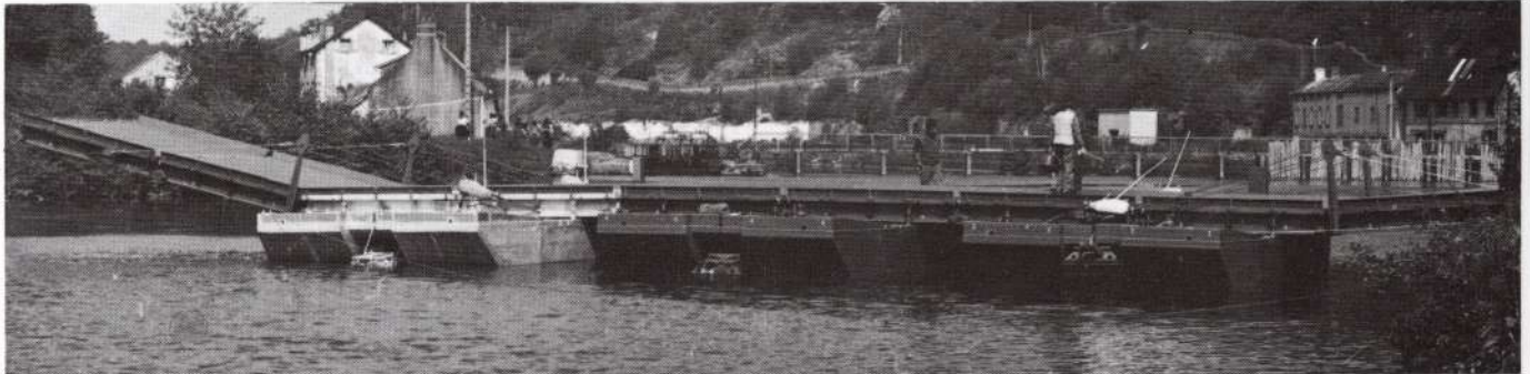
Réalisation d'une portière - Accès à la rive. Mounting of a raft - access to river bank - Realización de una compuerta - Acceso a la orilla.
