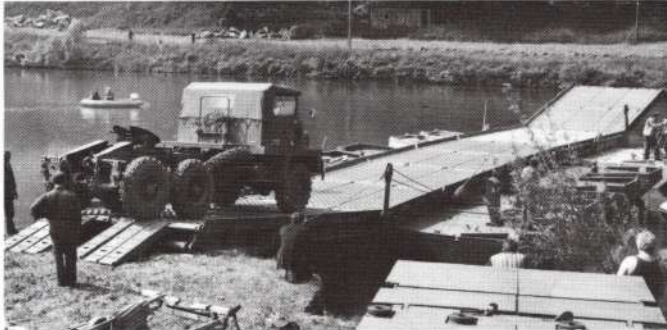
Réalisation d'une portière de classe 50 - Vue générale du chantier Construction of a Class 50 raft - General view of the working site - Realización de una compuerta clase 50
