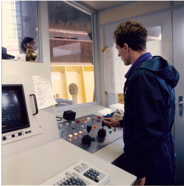
17-PC sur plate-forme 380 v - Pilot on platform 380 v
