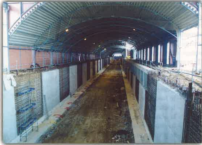
FIG. 11. – Vue du bassin en construction
