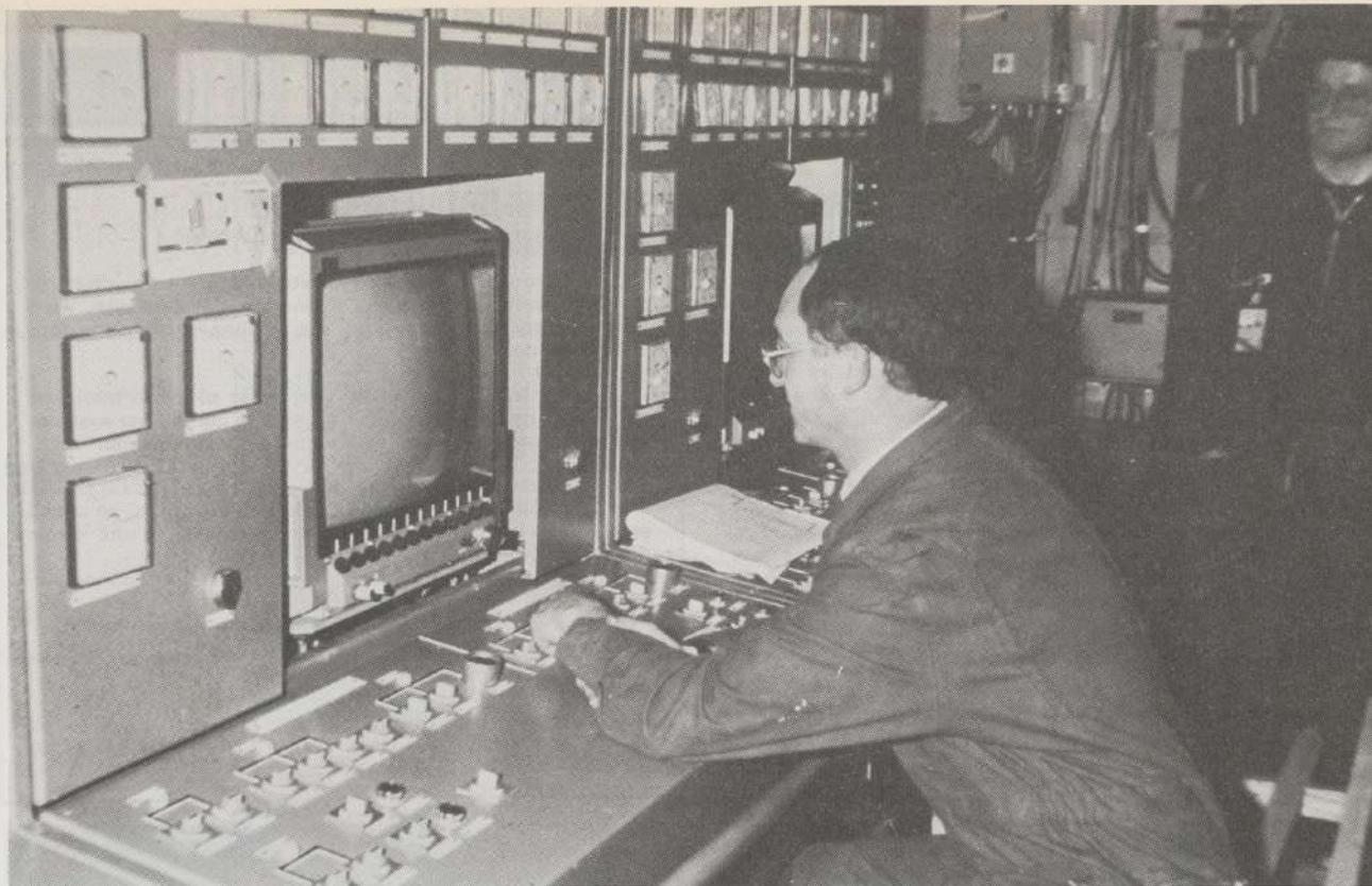
Console du SNCDE (Système numérisé de connaissance des données énergie) du P.C. énergie-propulsion.
