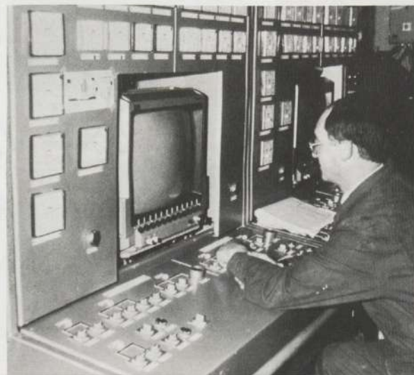
Console du SNCDE (système numérisé de connaissance des données énergie) du PC énergie-propulsion / (PHOTO COLS BLEUS)
