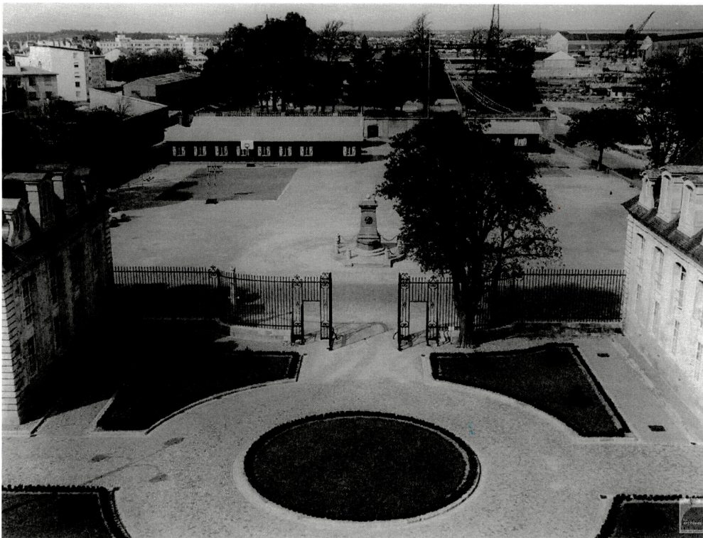
Le monument devant l'hôtel Gabriel, sans la statue (Source : Archives municipales 15Fi9064)
