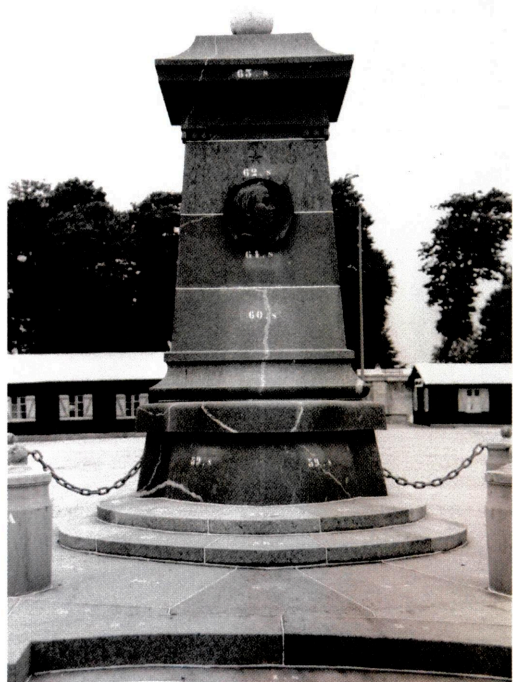
Le piédestal avant le démontage Au fond les « baraques » (sources archives SHD de Lorient)
